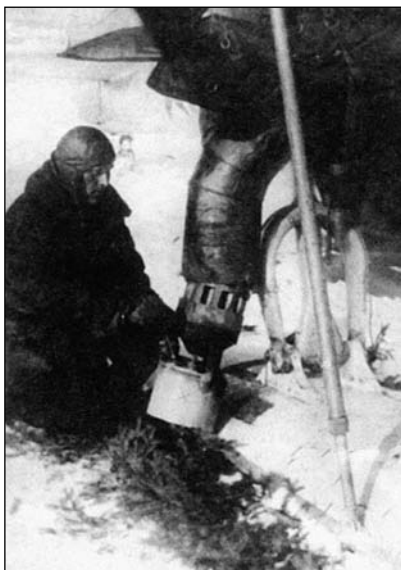
Подогрев двигателя с помощью лампы АПЛ-1. Под лыжи уложен еловый лапник во избежание их примерзания
