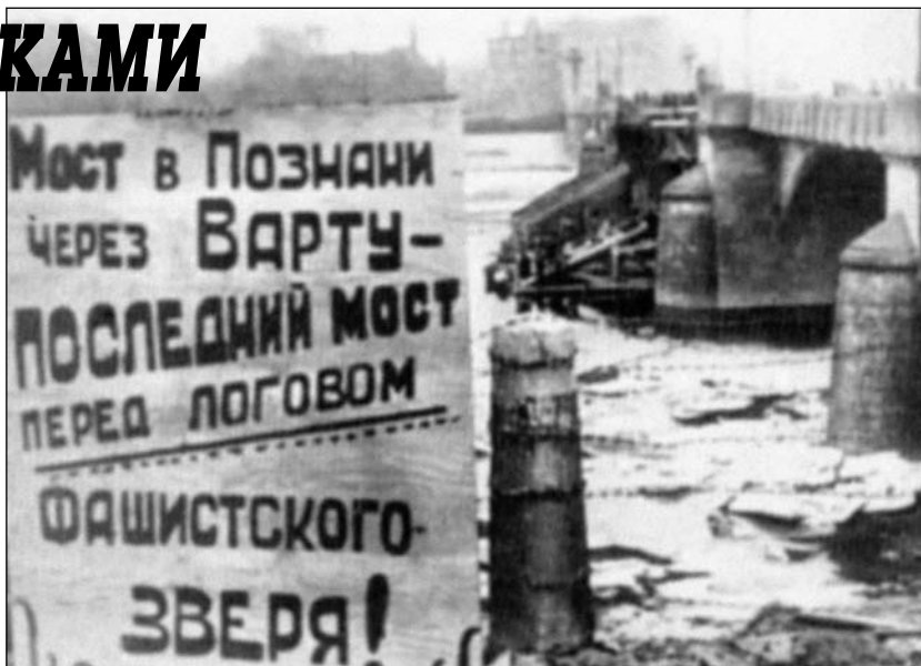
Восстановление моста через р. Варту в г. Познани
