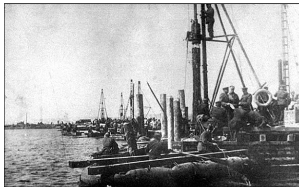
Забивка свай на строительстве низководного моста через р. Одер в районе Фрауэнхофа Апрель 1944 г.
